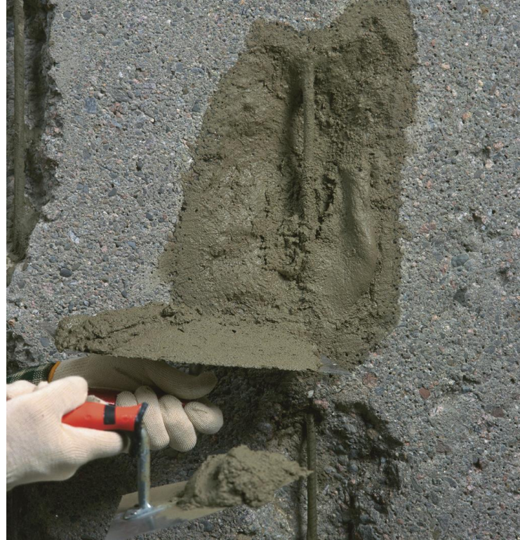
Antikorozinis, tiksotropinis remontinis betonas
