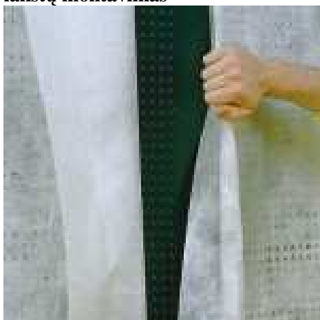
27 pav. Drenažinių apsauginių lakštų montavimas
