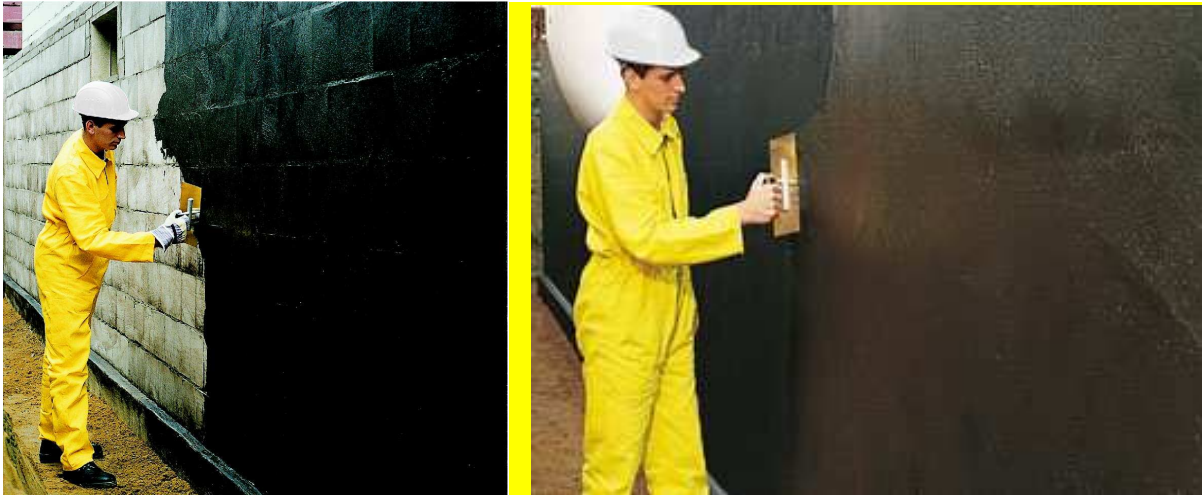
21 pav. Bituminės hidroizoliacijos Weber tepimas ant sienos dviem sluoksniais.
