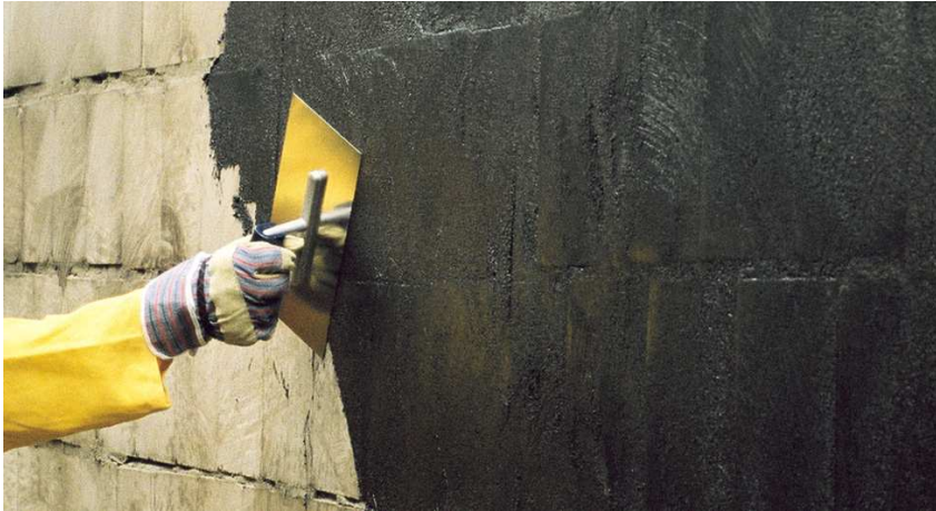
10 pav. Nubraukiamojo (užtaisomojo) sluoksnio dengimas.
