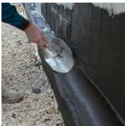
20 pav. Kampų užapvalinimas Weber bituminiais hidroizoliaciniais mišiniais.
