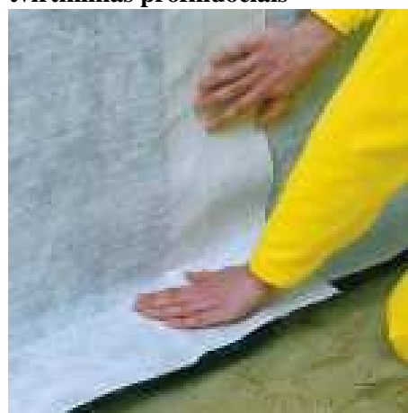
28 pav. Drenažinių apsauginių lakštų tvirtinimas profiliuočiais
