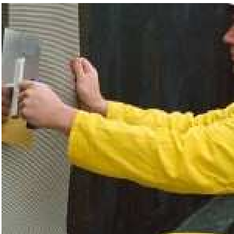
24 pav. Armavimo tinklelio įterpimas į bituminę hidroizoliaciją.
