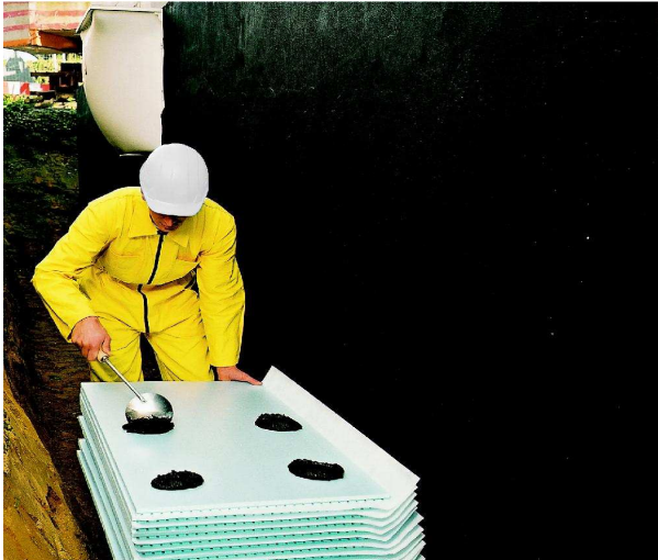
25 pav. Polistireninio putplasčio XPS klijavimas, plokščių tepimas klijais.
