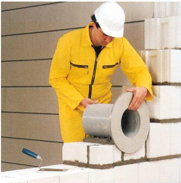
11 pav. Vamzdžio (su flanšu) montavimas į sieną.
