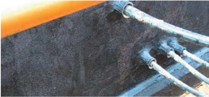
12 pav. Vamzdžių montavimas į sieną.
