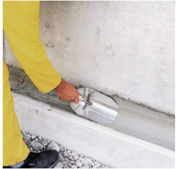
3 pav. Rišamojo sluoksnio sudarymas su Weber.tec 824. 4 pav. Kampų užapvalinimas Weber.tec 933.
