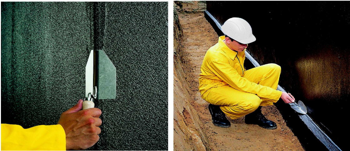
21 pav. Bituminės hidroizoliacijos Weber tepimas ant sienos dviem sluoksniais.
