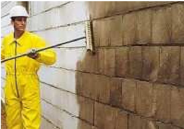
5 pav. Gruntavimas Weber.tec 901.
