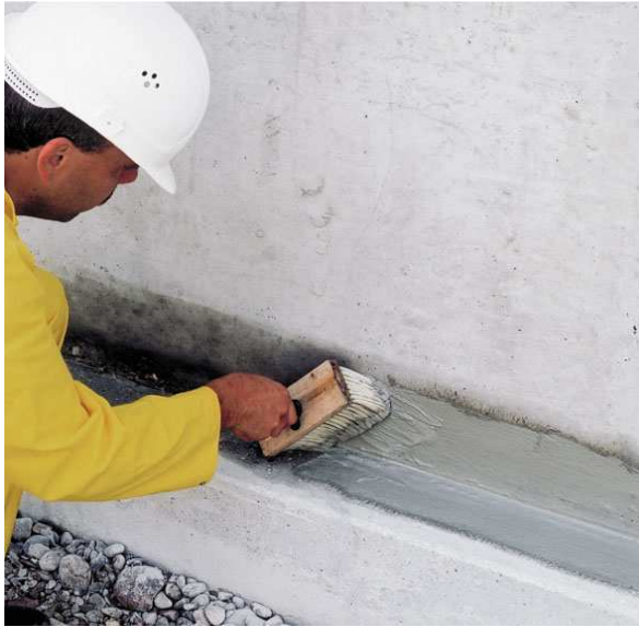
3 pav. Rišamojo sluoksnio sudarymas su Weber.tec 824. 4 pav. Kampų užapvalinimas Weber.tec 933.
