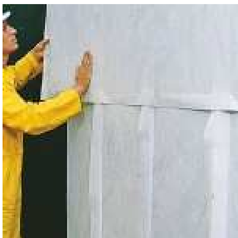
27 pav. Drenažinių apsauginių lakštų montavimas
