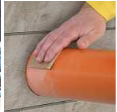
13 pav. Vamzdžių paviršiaus šiurkštinimas.
