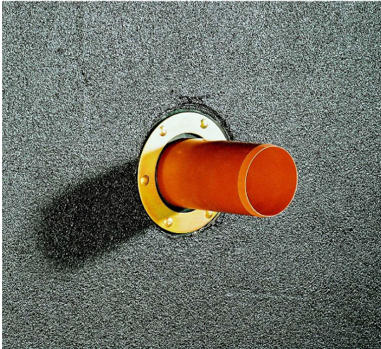
15 pav. Hidroizoliacijos tepimas aplink vamzdį, papildomo flanšo įrengimas esant beslėgiam, filtraciniam vandeniui bei vandeniui su patvanka, nedideliam slėgiui slėgio tipas C.
