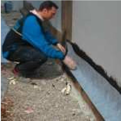
23 pav. Papildomas kampų armavimas tinkleliu.
