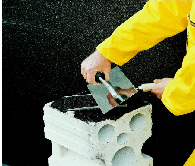
32 pav. Hidroizoliacijos išdžiuvimo tikrinimas.
