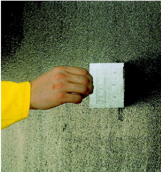
31 pav. Hidroizoliacijos sluoksnio storio matavimas.
