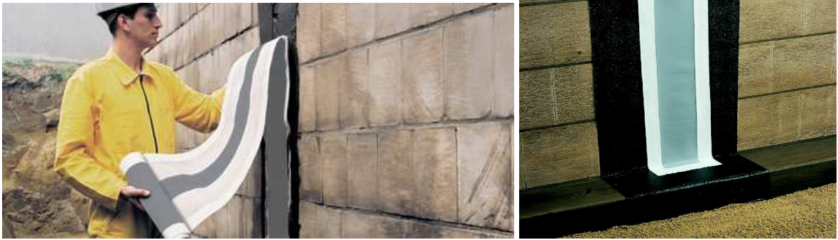
17 pav. B tipo hidroizoliacinės juostos klijavimas, įspaudimas į mastiką
