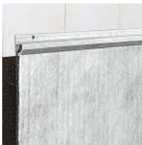
28 pav. Drenažinių apsauginių lakštų tvirtinimas profiliuočiais
