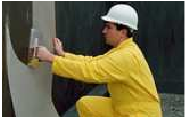
24 pav. Armavimo tinklelio įterpimas į bituminę hidroizoliaciją.
